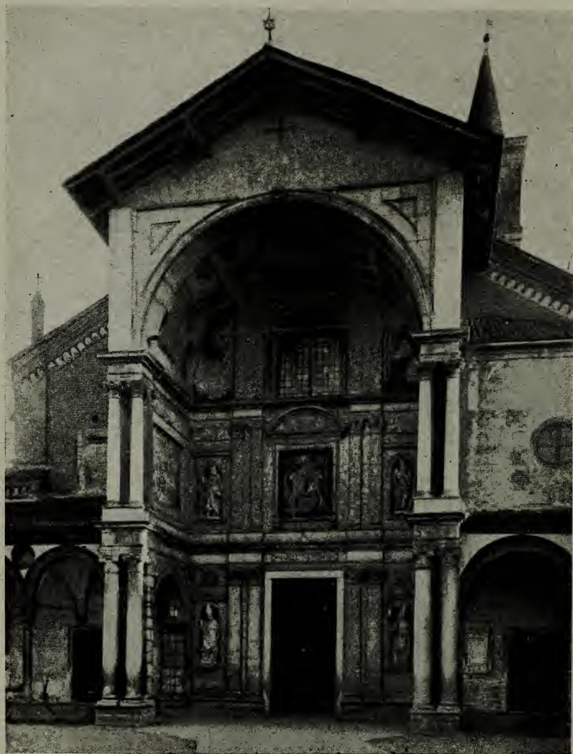
SANTA MARIA DI ABBIATEGRASSO: LA FACCIATA
